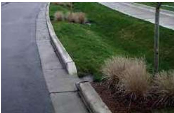
Используемые растения должны быть устойчивыми к влажной среде и химическим реагентам. Ширина канавы принимается не менее 2 м, глубина — 0,3–1 м, в зависимости от размеров. Излишки воды следует отводить в линейный водоотвод, имеющийся на территории ОДС.
