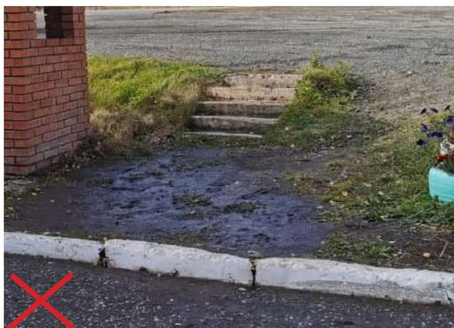
Недопустимо отсутствие покрытия для пешеходов. Необеспеченность подходов к объекту инвалидов и МГН: отсутствие пандусов, ограждений, тактильной плитки.
