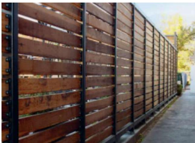
Конструкция состоит из металлических вертикальных стоек с заполнением из деревянной доски (горизонтальным, вертикальным, под углом).
