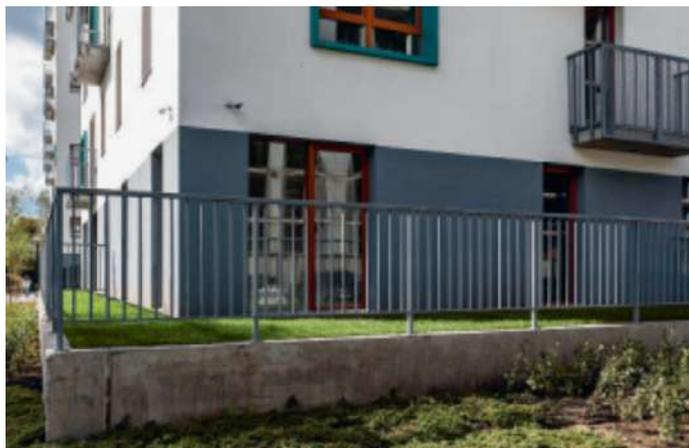
Конструкция состоит из стоек с вертикальным заполнением из стального круглого профиля, установленных на парапет. Материалы: каркас, заполнение — сталь (горячего/холодного цинкования, порошковое покрытие), бетон (парапет).
