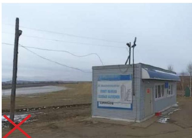
Недопустимо устраивать освещение с помощью прожектора на деревянной опоре и стойке на павильоне.
