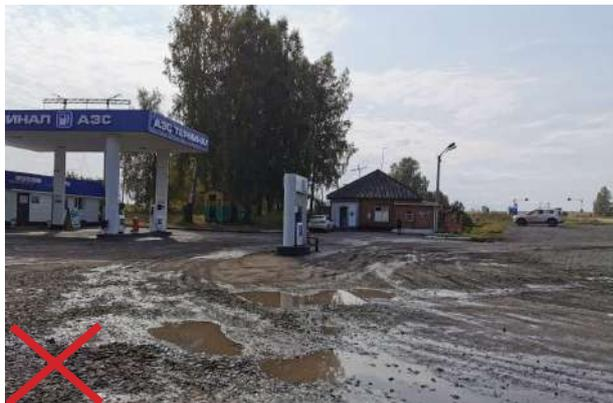
Необходимо устройство твердого покрытия территории с разметкой. Участок должен быть спланирован и благоустроен на основе вертикальной планировки с организацией системы водоотведения.
