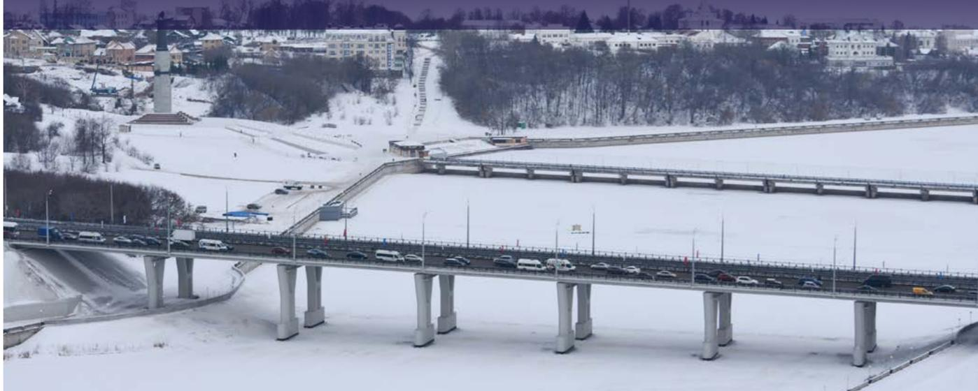
**6-полосный** мост связывает два крупных района **Чебоксар** — **Московский** и **Калининский**. Безопасность движения обеспечивают **56 опор** освещения, более **1 км** барьерного ограждения, **67 дорожных знаков**, современный светофорный объект. Для удобства жителей дорожники устроили пешеходные тротуары и нанесли разметку.
