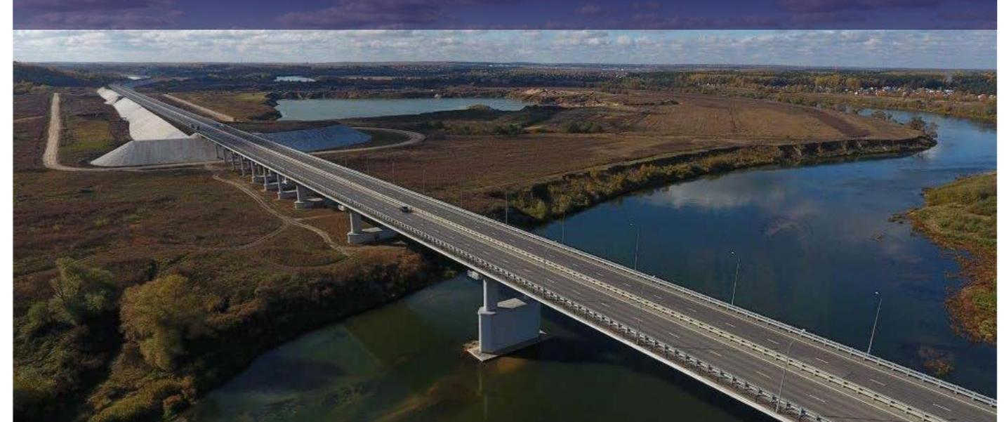
Построено более **21 км** автодорог категории **ИБ**, **3 разноуровневые развязки**, **8 путепроводов**, **мост** через **Оку**. Реконструировано почти **9 км** участков федеральных автодорог. На протяжении всего **Южного обхода** дорога имеет **4 полосы движения**.
