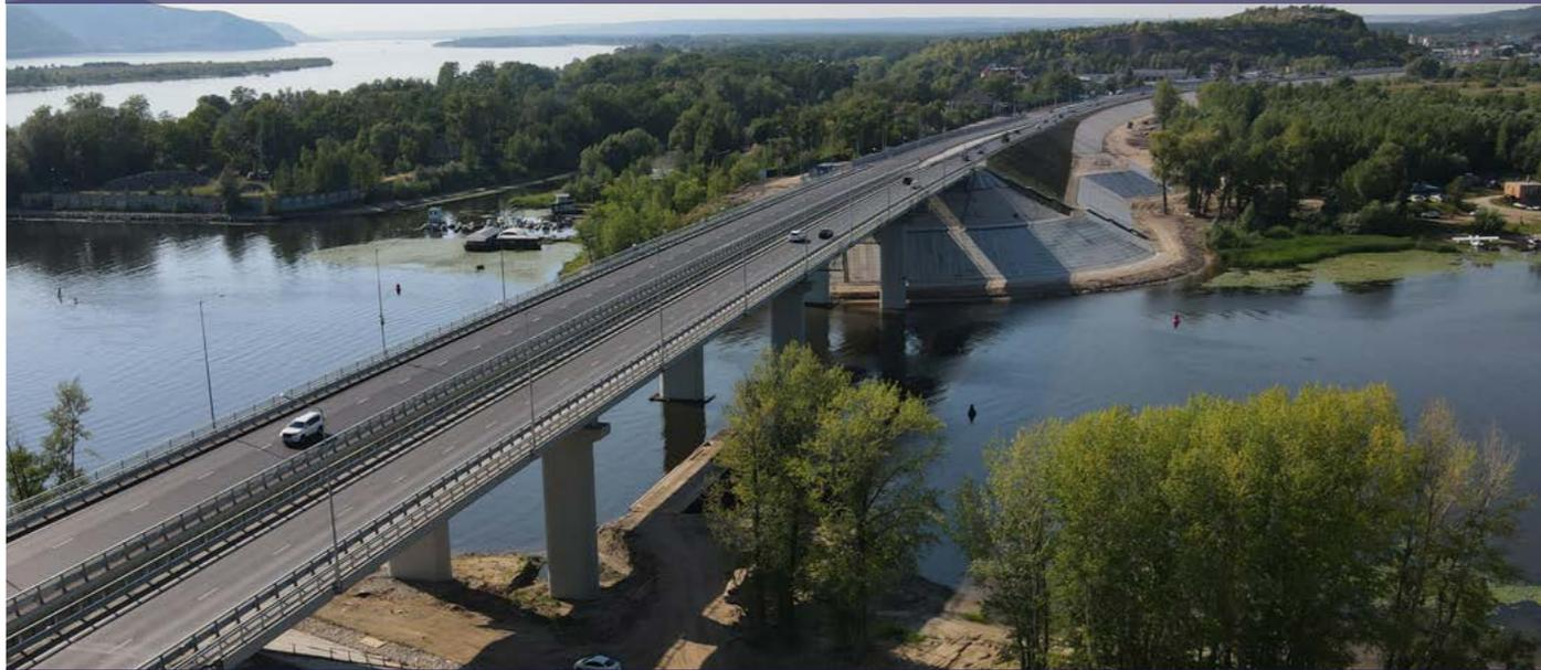
Протяженность моста — **306 м**, он состоит из **5 монолитных железобетонных опор** высотой до **20 м** и металлического пролетного строения общим весом около **1 700 т**.
