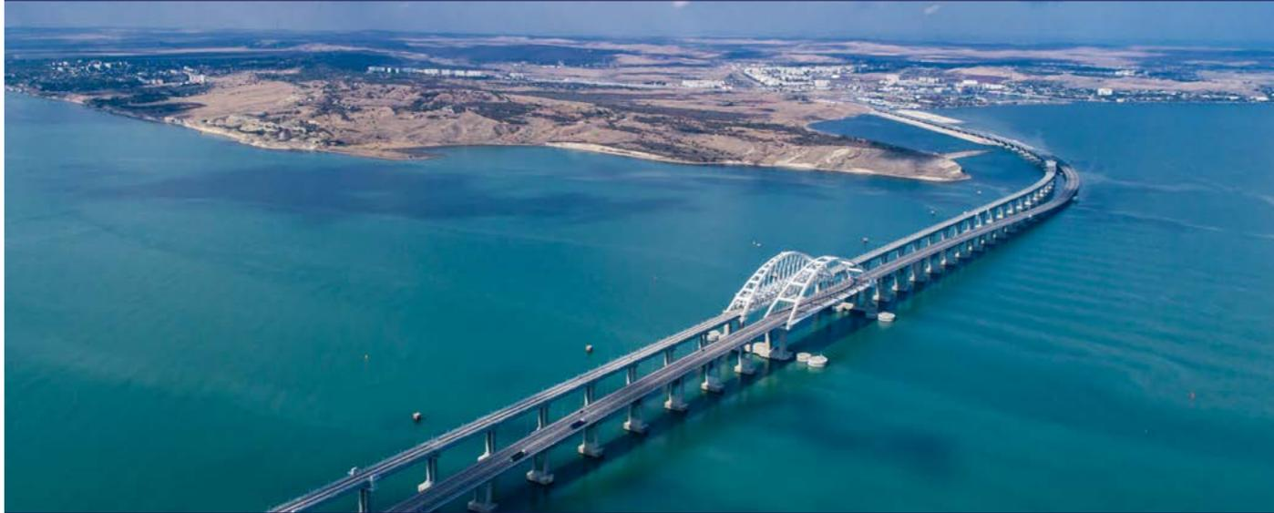
Стройка века **№ 1 в России**, состоит из автомобильной трассы и железнодорожной части. Дорога для машин **4-полосная**, разрешенная скорость **до 90 км/ч**. Способен пропускать **до 100 поездов в сутки**, их скорость движения — **120 км/ч**.
