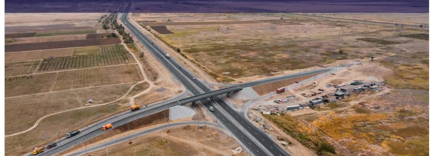
Участок пролегает между населенными пунктами **Малый Уйташ** и **Манас**. В рамках реконструкции выполнено строительство **2 путепроводов** общей длиной свыше **125 м**, транспортной развязки и разворота в разных уровнях — для безопасного и комфортного проезда по участку. Для животных устроен **скотопрогон** длиной около **28 м**. Вблизи населенных пунктов установлено **1 550 м шумозащитных экранов**.
