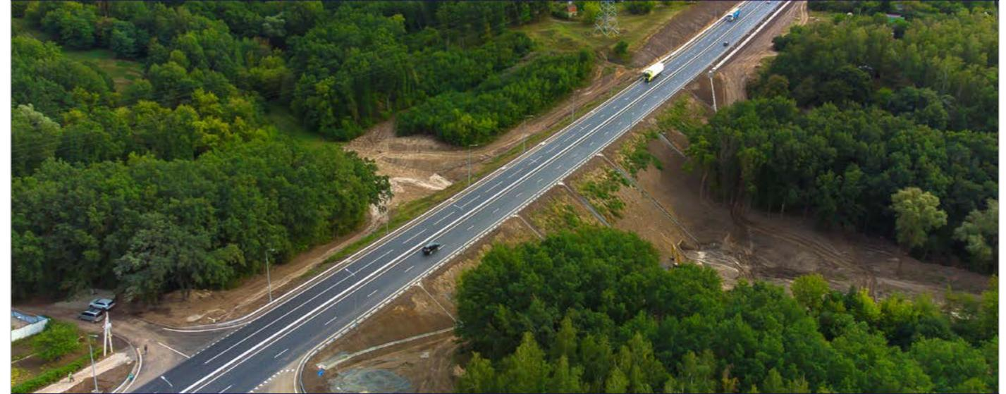
Главным итогом работ стало увеличение количества полос движения **с 2 до 4** и установка разделительного барьерного ограждения. Расширение проезжей части произошло **впервые** за весь срок службы построенной дороги, который составил **более 50 лет**.
