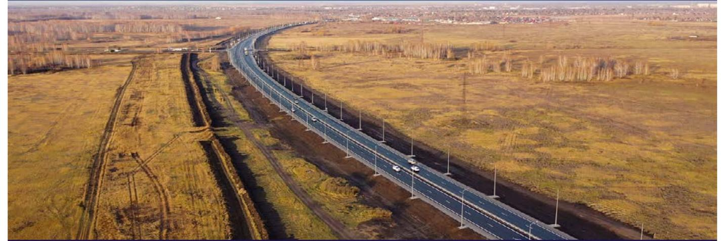
В ходе капремонта ширину проезжей части увеличили **с 2 до 4 полос**, разделив встречные потоки транспорта осевым барьерным ограждением. На всем протяжении участка установлена линия электроосвещения, отремонтированы водопропускные трубы, заменены элементы инженерного обустройства. В результате **пропускная способность** участка возросла **вдвое**.
