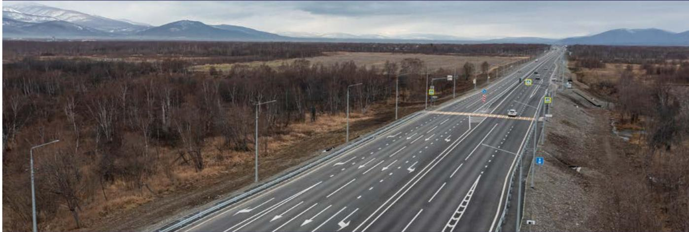
Во время проведения капитального ремонта дорожники устроили земляное полотно, водосбросы и дорожное покрытие из щебеночно-мастичного асфальтобетона, отремонтировали **27 водопропускных труб** и построили **две** новые, установили **18,5 км осевого барьерного ограждения** и **18,2 км стационарного электроосвещения**, а также оборудовали **29 остановочных павильонов**.
