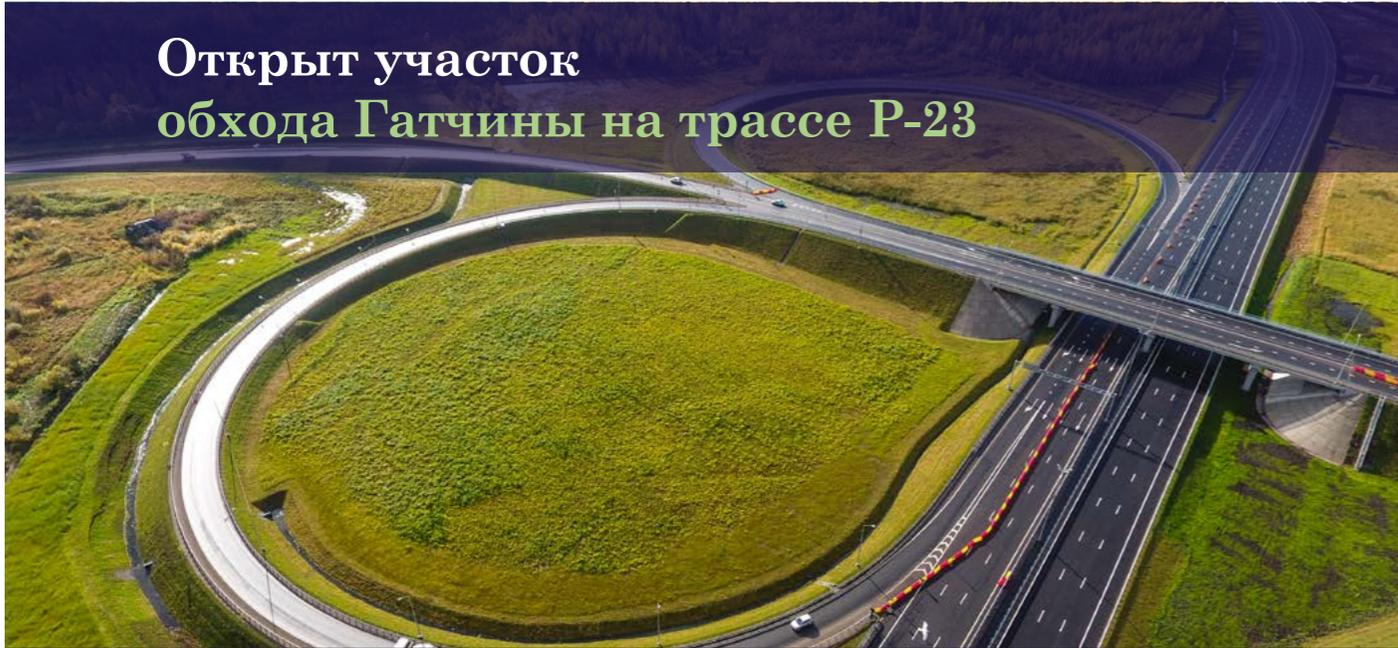
В составе нового **6-полосного участка** трассы возведены **4 путепровода**, в том числе в составе транспортных развязок в разных уровнях. Для повышения безопасности участников движения на данном участке установлены барьерные ограждения, разделяющие встречные потоки, протяженностью около **52 тыс. пог. м**, смонтировано более **20 км линий наружного освещения**, построено **2 надземных пешеходных перехода**.
