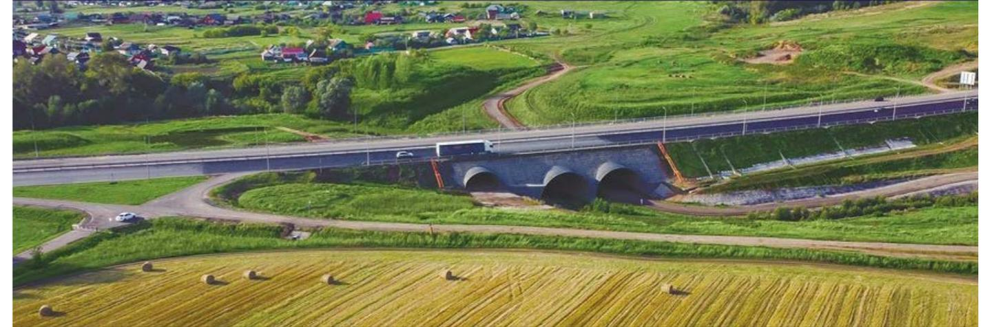
Протяженность участка — **11 км**. В ходе реконструкции 2-полосная дорога доведена до **6 полос**, построена **разноуровневая транспортная развязка** рамочного типа на примыкании к автодороге к поселку Сергеевка. Также **отремонтирован арочный мост** через реку Малый Кидаш, устроены скотогон и тоннель для проезда сельхозтехники ниже уровня трассы. Возле поселка Восточное возведен надземный **пешеходный переход**.
