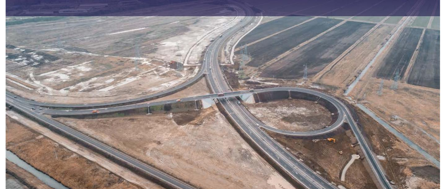
Транспортная развязка на трассе **A-290** Новороссийск – Керчь в Краснодарском крае. Верхний слой выполнен из **ЩМА-20** — асфальтобетона, обладающего свойствами «**самозалечивания**» трещин и мелких дефектов.
