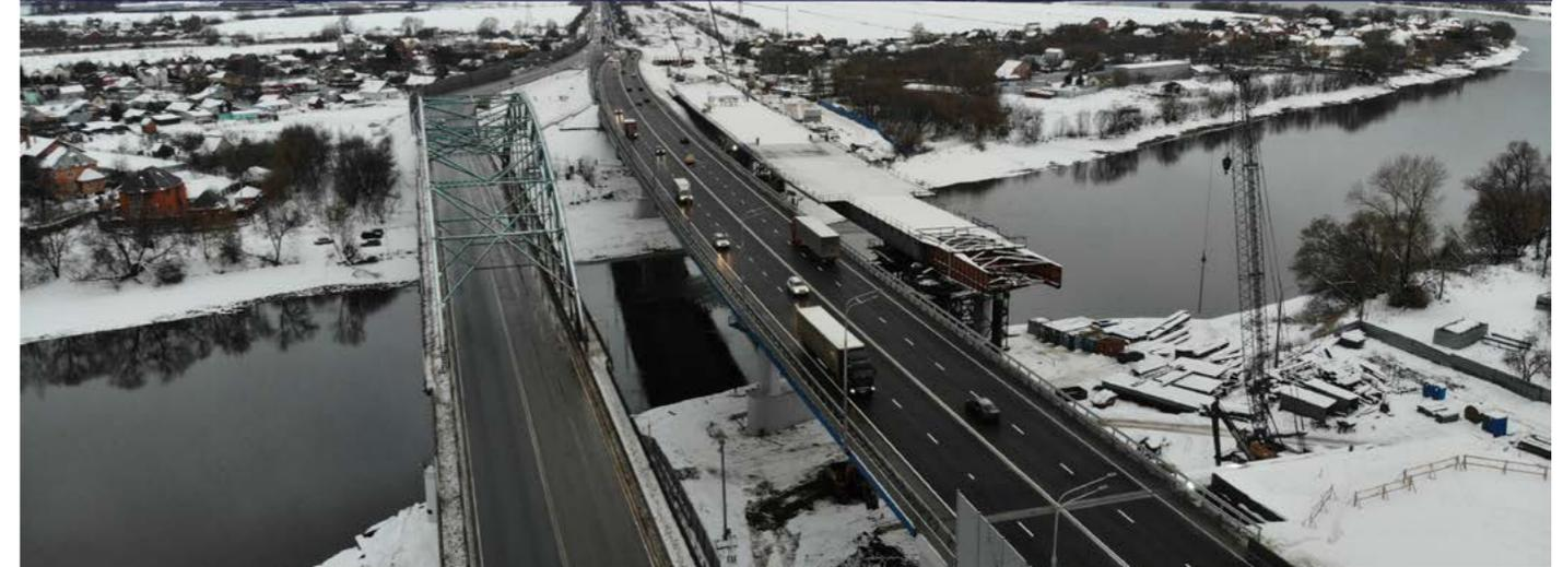
Пролетное строение моста состоит из стальных металлоконструкций **общим весом 3,5 тыс. т**. Протяженность моста с подходами составляет **более 1 км**. На объекте установлено сплошное электроосвещение. Для защиты биоресурсов Москвы-реки от вредных веществ построены локальные водоочистные сооружения.
