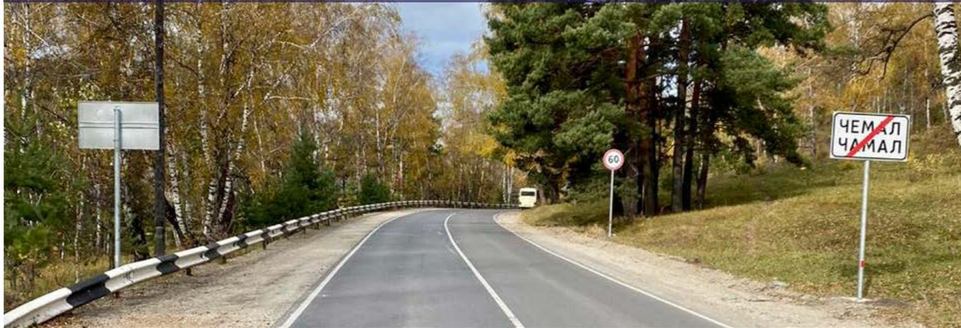
Основание участка укрепили методом холодной регенерации и уложили **два слоя асфальтобетонной смеси**, изготовленной по новым стандартам. **Отремонтировали** водопропускные трубы. В летний сезон транспортный поток в этом направлении возрастает в разы. Поэтому на участке были устроены тротуары и **18 остановочных площадок**, оборудованы съезды, отремонтированы примыкания.
