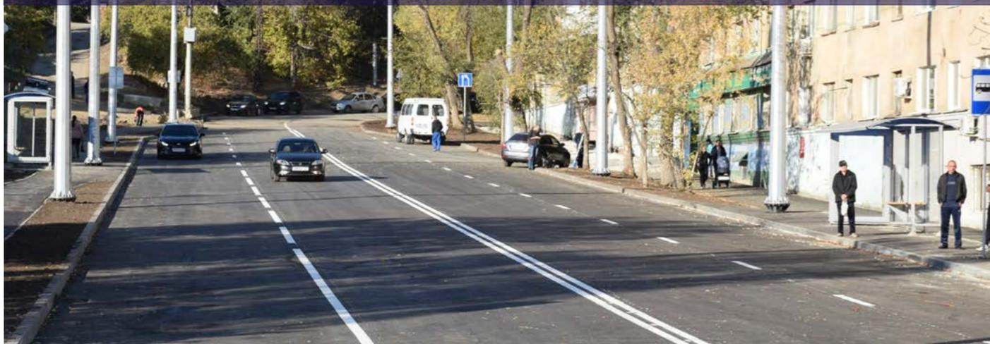
Мост практически возвели заново. Специалисты демонтировали старые и построили новые опоры основания и железобетонные конструкции сооружения. **Обеспечен беспрепятственный проезд** крупногабаритного транспорта под путепроводом. Для этого дорожное полотно **улицы Шехурдина** углубили более чем на **метр** от первоначального уровня.
