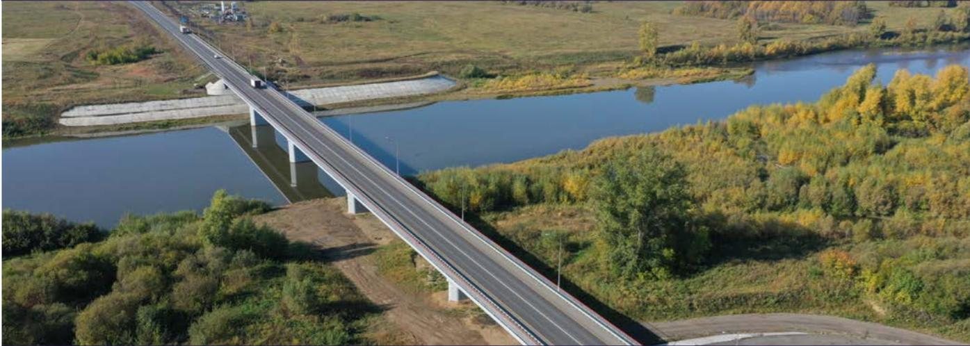
Протяженность обхода около **20 км**. В его составе — **2 транспортные развязки** с путепроводами и железобетонный **мост через реку Кию** длиной **285 пог. м**. За счет строительства путепровода над железной дорогой ликвидировано одноуровневое пересечение с Транссибирской ж/д магистралью.
