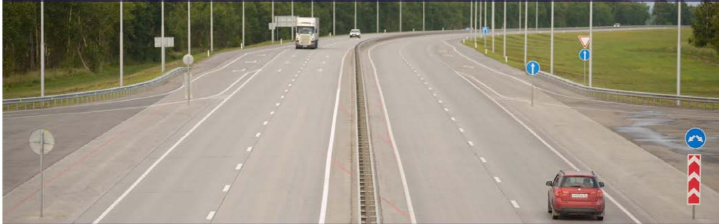
Скоростная **4-полосная дорога** высшей технической категории, протяженность участка – **6 км**. Организована **транспортная развязка** с **надземным путепроводом**, а также установлено специальное **барьерное ограждение** для разделения встречных автомобильных потоков. Учитывая специфику прилегающих к трассе сельскохозяйственных районов, дорожники обустроили **скотопрогон** и **путепровод** для пропуска сельхозтехники.
