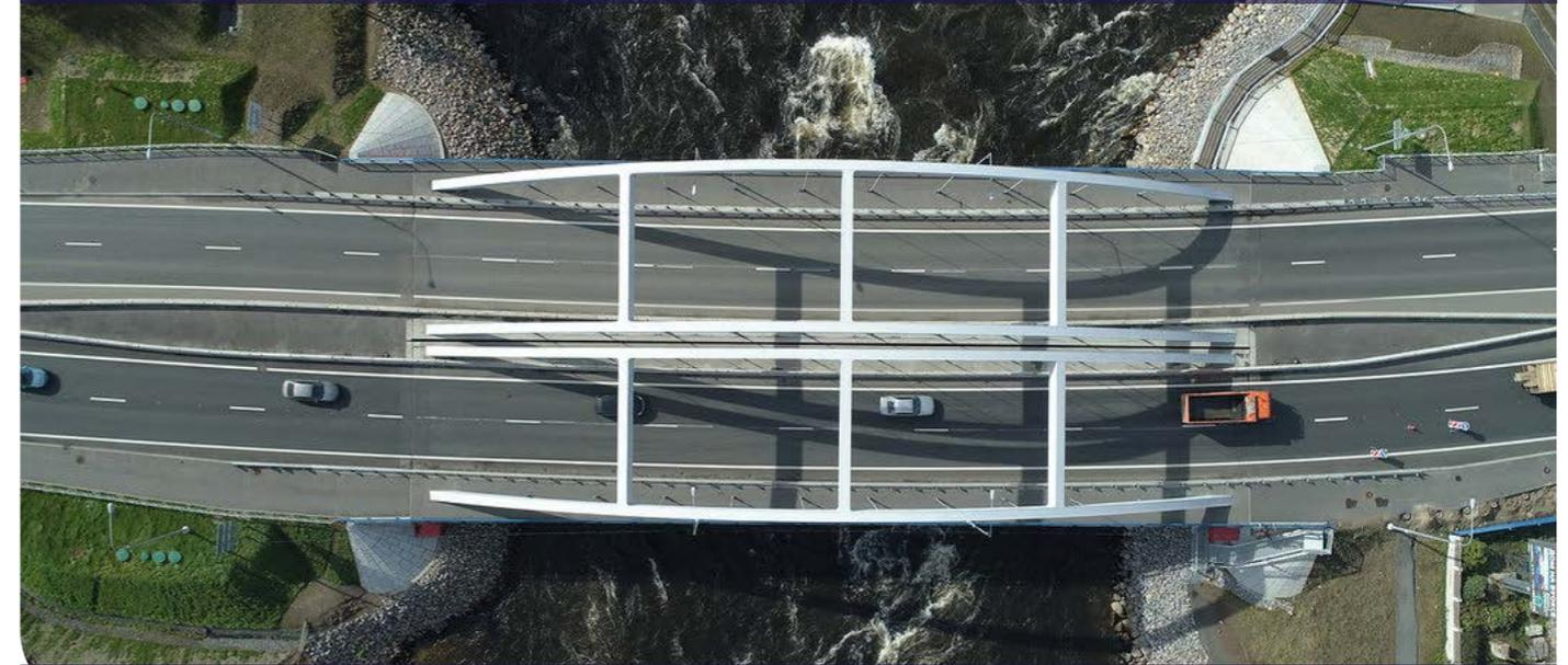
Украшенный архитектурно-художественной подсветкой мост через **Вуоксу** имеет **два отдельных арочных пролетных строения** индивидуального проектирования с гибкими подвесками из высокопрочных вант.
