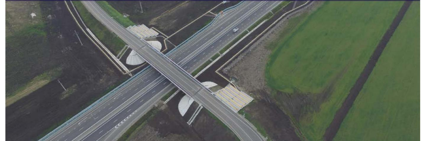
В составе участка — **3 транспортные развязки** в разных уровнях, дорогу расширили до **4 полос**. Устроено **14 км освещения**, **44 км барьерного ограждения**, почти **3 км снегозащитных насаждений**, **8 км шумозащитных** и около **1 км противоослепляющих экранов**. Установлены автобусные остановки, участок оборудован автоматизированной системой управления дорожным движением (**АСУДД**).
