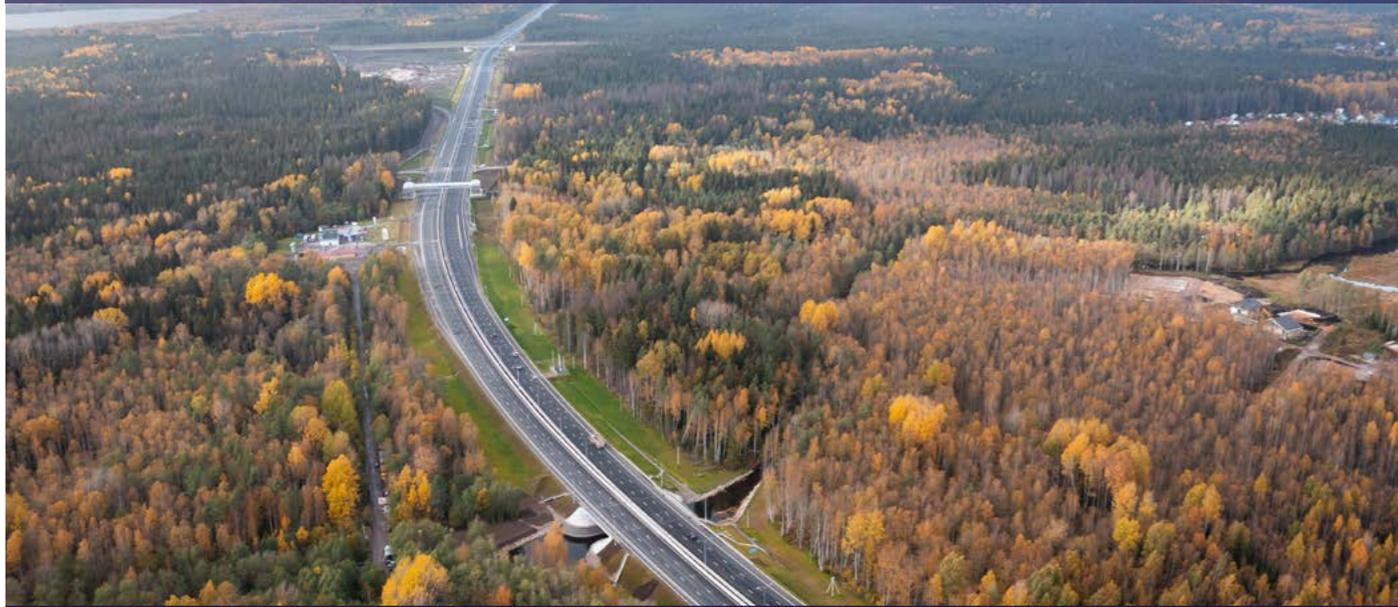
В ходе реконструкции участок расширен с 2 до 6 полос движения, построены 3 развязки, 2 надземных пешеходных перехода, реконструирован мост через реку Великую.
