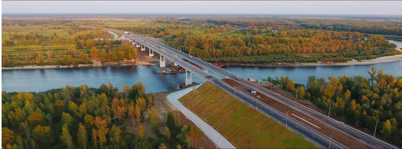
Реконструкция проводилась в **два этапа**. Специалисты заменили пролетное строение и конструкцию дорожной одежды, а также укрепили откосы бетонными плитами. Смонтированы линии электроосвещения, установлено барьерное и перильное ограждение. Среднесуточная интенсивность движения по данному участку доходит до **10 тыс. автомобилей**.
