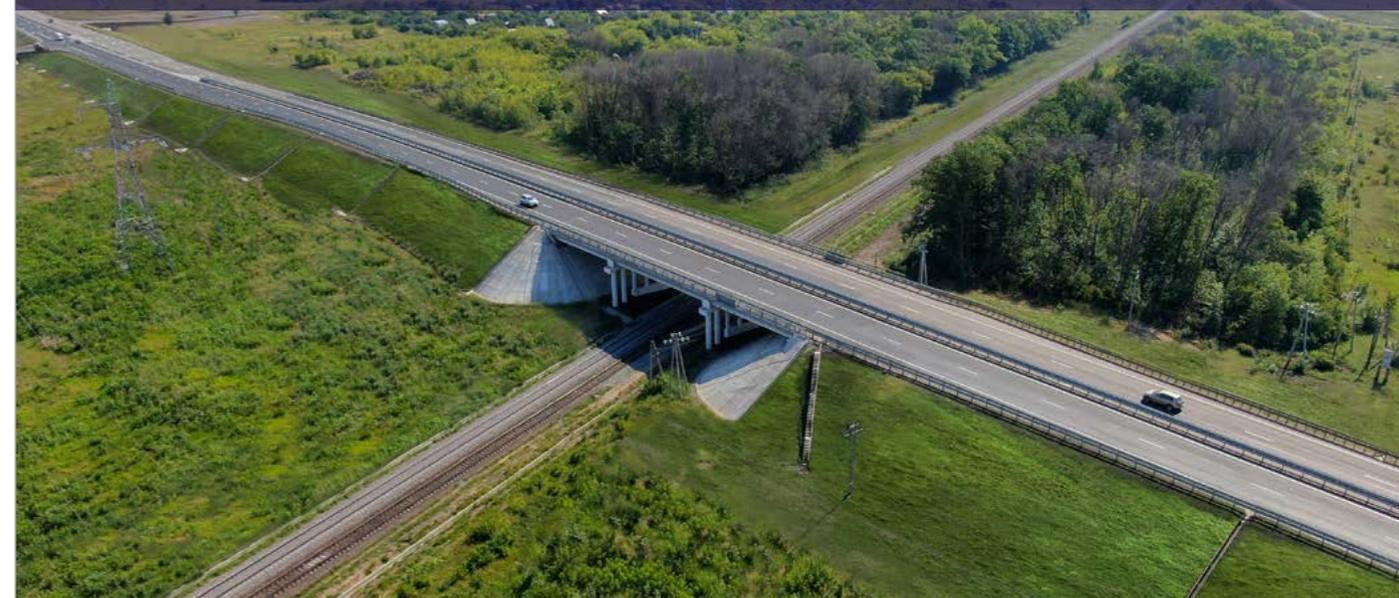
Проезжую часть расширили с **2 до 4 полос**. Встречные потоки на обходе разделены осевым барьерным ограждением, построены три новые разворотные петли, которые ликвидируют самые опасные — левые повороты.
