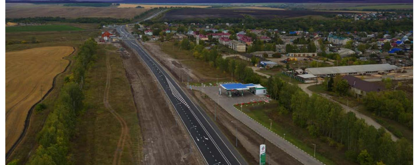
Установлено **105 опор дорожного освещения**, **167 дорожных знаков** и более **2 км металлического барьерного ограждения**. Отремонтирована площадка возле автостанции **Тереньга**, устроены пешеходные переходы и тротуары с перильным ограждением.
