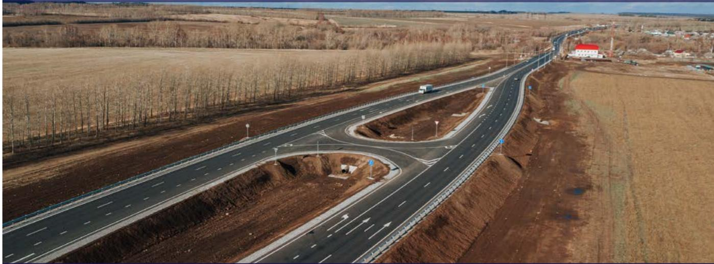
В ходе капремонта **увеличено количество полос** движения с 2 до 4. В местах расширения выполнено устройство новой дорожной одежды и усиление существующей. Асфальтобетонные слои были подобраны **по технологии объемного проектирования** с учетом особенностей климата и уровня интенсивности движения.
