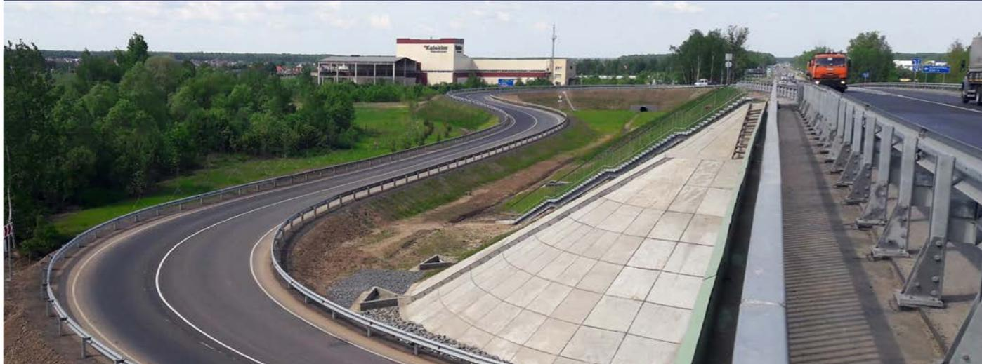
Общая протяженность сооружения — **1 530 м**, установлены более **3 км** металлического барьерного ограждения и **54** дорожных знака. Дорожники обустроили **2 автобусные остановки** с переходно-скоростными полосами. Не забыли об экологичности объекта — построены очистные сооружения и шумозащитные экраны протяженностью **930 м**.
