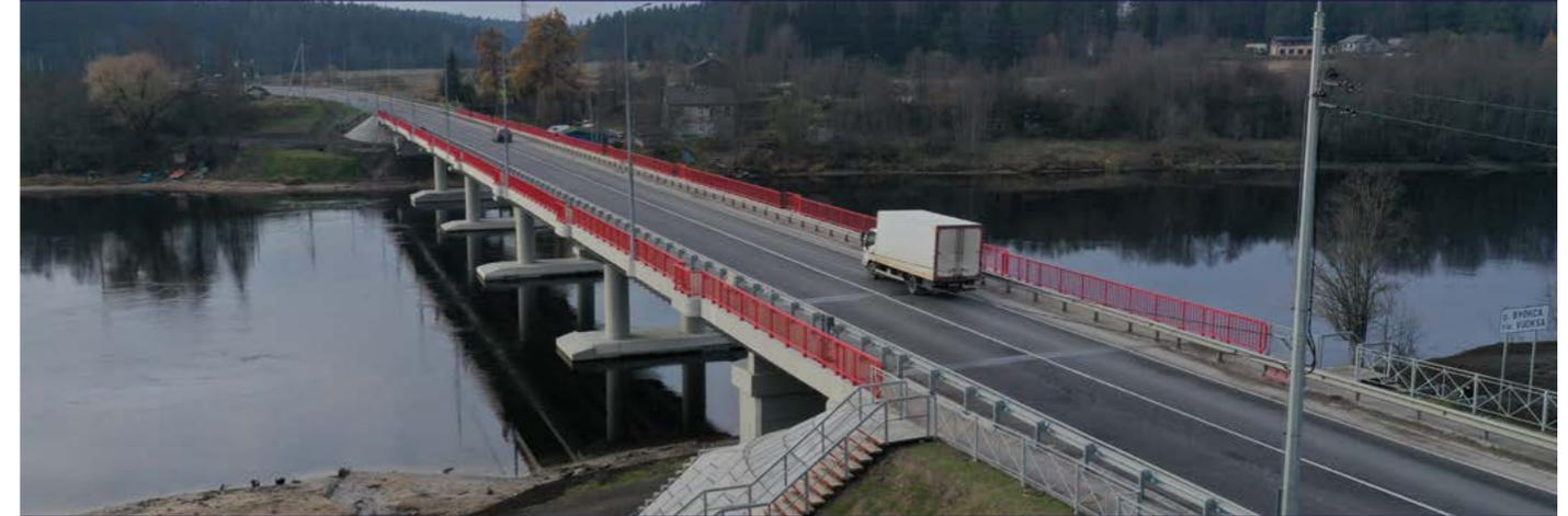
В ходе **капремонта** был полностью **разобран существующий мост**, выполнен ремонт **9 опор**, водопропускных труб на подходах, а также устроено новое пролетное строение. Габарит проезжей части **увеличен с 8,5 до 10 м**. На мосту смонтированы барьерное и перильное ограждения общей протяженностью **842 м**, линии освещения, а также уложено новое асфальтобетонное покрытие, в том числе на пешеходных тротуарах.
