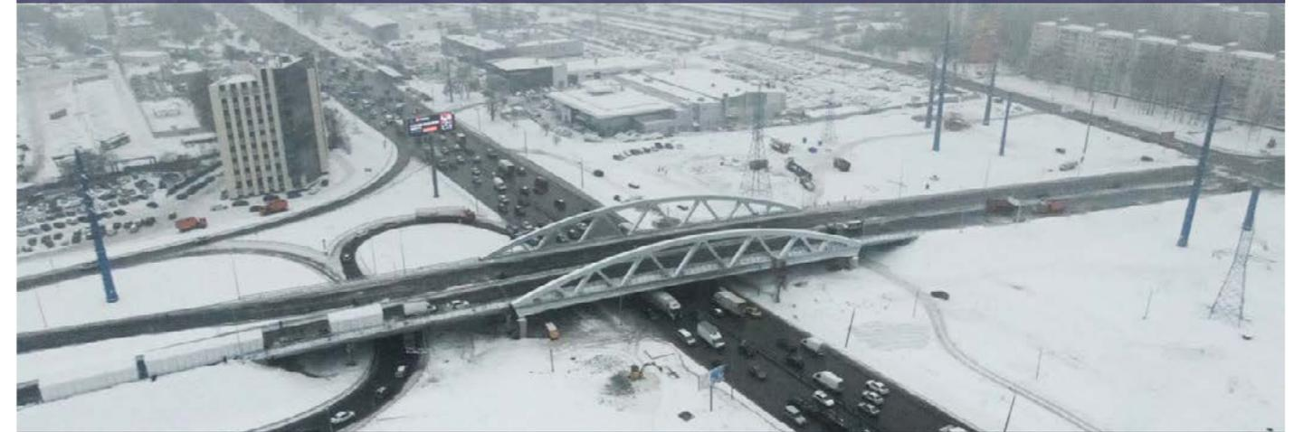
Общая площадь построенной транспортной развязки — порядка **40 тыс. кв. м**. Протяженность основного хода — почти **1 км** с путепроводом длиной **158 м**. **От 2 до 5 полос движения** с расчетной скоростью **70 км/ч**, устроены пешеходные зоны, светофоры, установлено наружное освещение и архитектурная подсветка. Также **проведена реконструкция** улиц **Дружбы, 9 Мая** и **Репина**.
