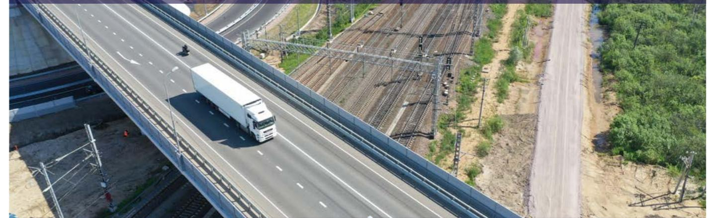
Длина пролетного строения составляет **164 м**, ширина – почти **20 м**, протяженность участка реконструкции вместе с подходами – около **2 км**. 2-полосная автодорога относится ко **II технической категории**. Построено **4 съезда**, возведена транспортная развязка. Смонтировано более **4 км линий наружного освещения**, свыше **7 км барьерного ограждения** и **552 м – осевого**. Установлены автопавильон и остановочная площадка для общественного транспорта.
