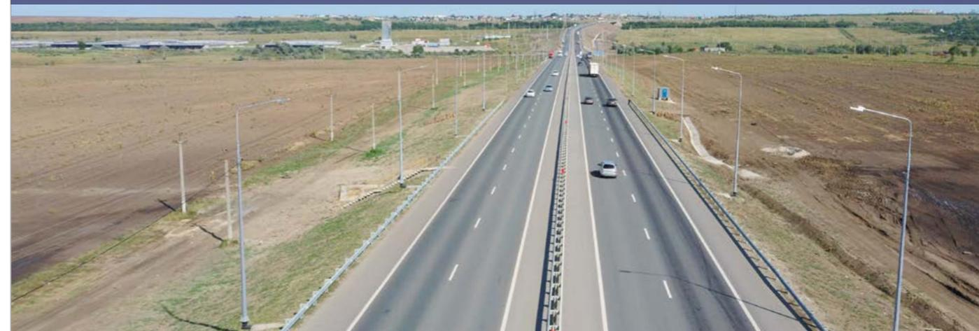
Работы на объекте были начаты в мае 2021 года и закончены с опережением графика. Дорожники переустроили все инженерные коммуникации, возвели земляное полотно путем отсыпки свыше 230 тыс. куб. м насыпи. На новом участке появилась транспортная развязка в разных уровнях, а также два моста и путепровод. Завершить все этапы реконструкции планируется до конца 2023 года.
