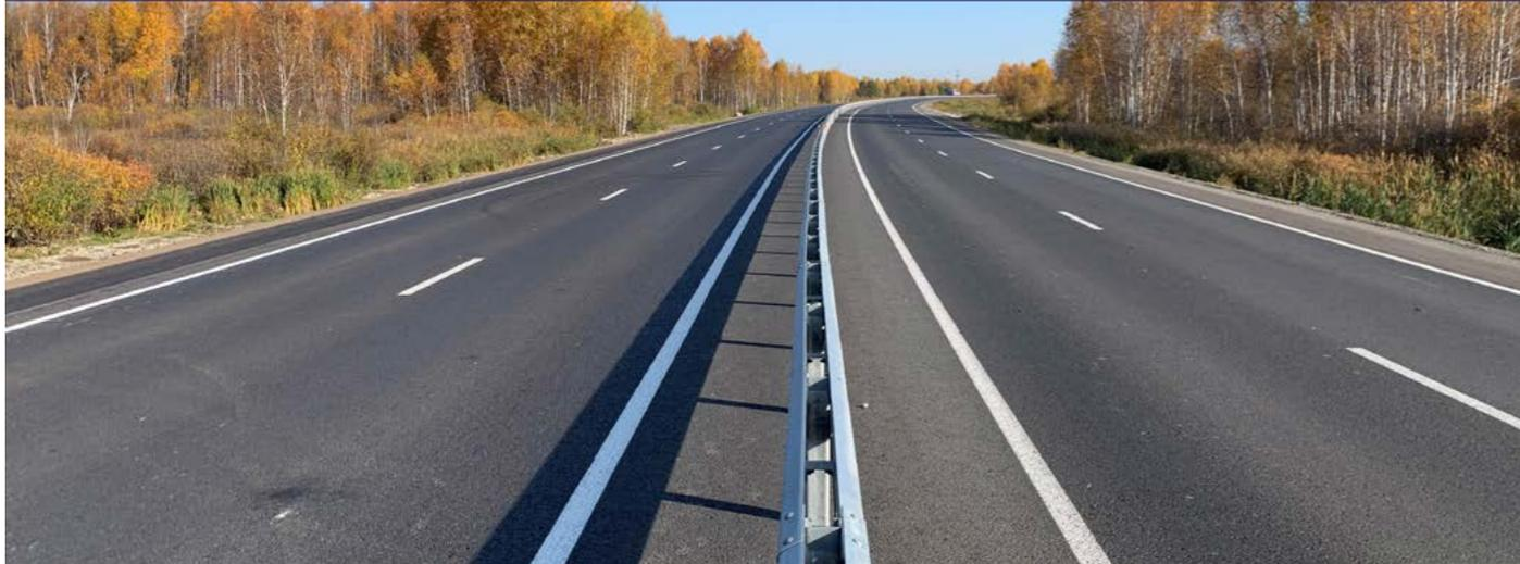
Почти за два года дорожники не только **расширили с 2 до 4 полос** почти **85 км** трассы, но и капитально отремонтировали **6 мостов**, построили **11 разворотных петель**, установили свыше **100 км барьерного ограждения** и более **20 км линий освещения**. В **Яркове, Сазонове** и **Щербаке** установили надземные пешеходные переходы.
