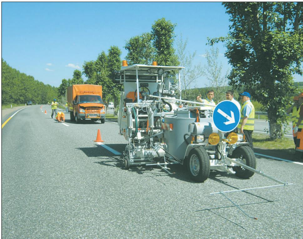
стичные материалы либо акриловую краску. Безусловно, термопластик, применяемый в основном на дорогах с большой интенсивностью движения, является более износостойким, чем краска. До сих пор он наносился на дорогу при помощи устаревшего оборудования, имеющего ряд недостатков – чрезмерный расход материала, неровность наносимых линий и т. д., что приводит к удорожанию процесса.
