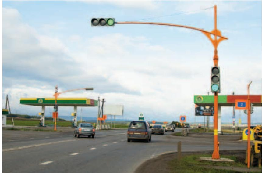
Разработка новинки для светофорного объекта заключается в автоматической системе переключения с альтернативного источника энергии на традиционный режим работы и обратно. На случай длительной пасмурной погоды и полного штита светофор будет переключаться на основной источник электроэнергии и в обратном порядке. В целях безопасности, при отключении основного питания, переход на альтернативу.
